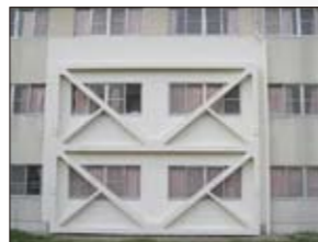
いままでの鉄骨による耐震補強
